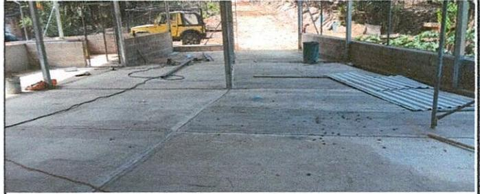
Foto 2: Reparación y cambio de losa de patio
